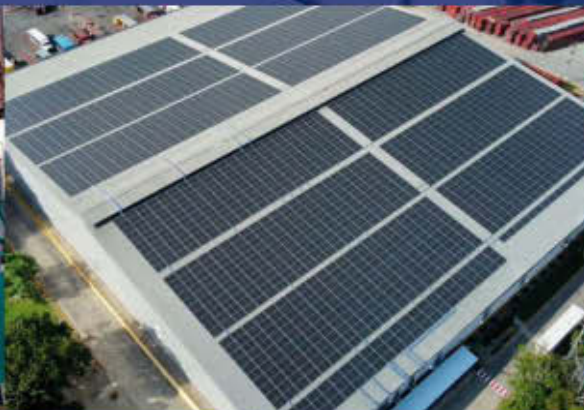
Instalación de Sistema Fotovoltaico 8.4 MWp.
