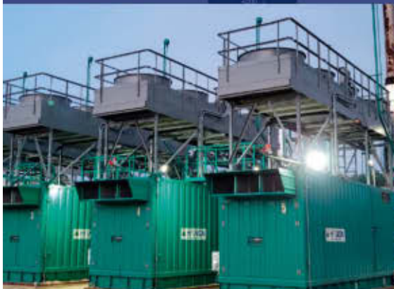
Instalación de Transformador 10.7 MVA 34.5/4.16 KV, Montaje de Switchgear 34.5 KV, Instalación de Cableado e Instalación de Red de Tierra.
