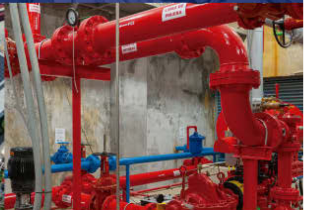
Instalación de Sistema de Bombeo para Combate de Incendios
