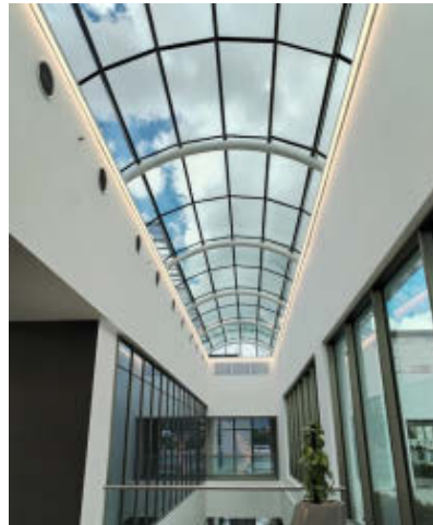
Sistemas Electricidad, HVAC, BMS en Anexo BCIE.
